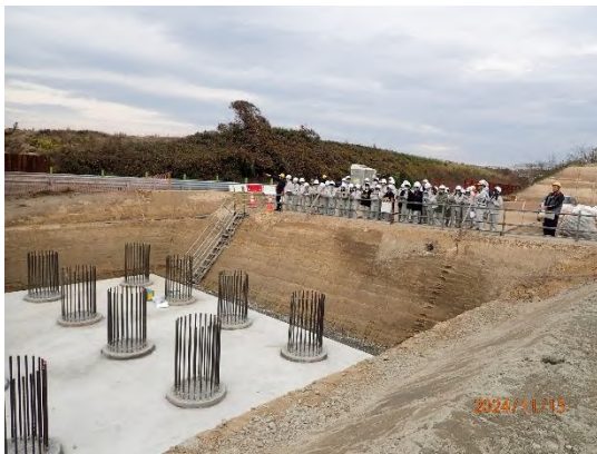
新設ランプ橋梁の施工状況を見学
